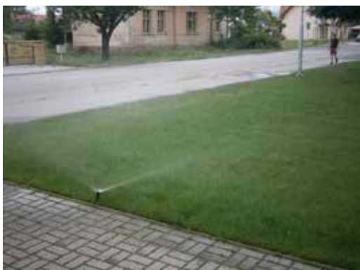
Trysky zavlažovacieho systému
